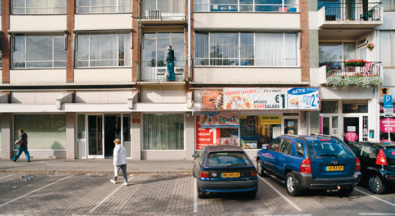
Steenstraat (oorspronkelijke locatie Eiffel, 1992-2000), Arnhem
