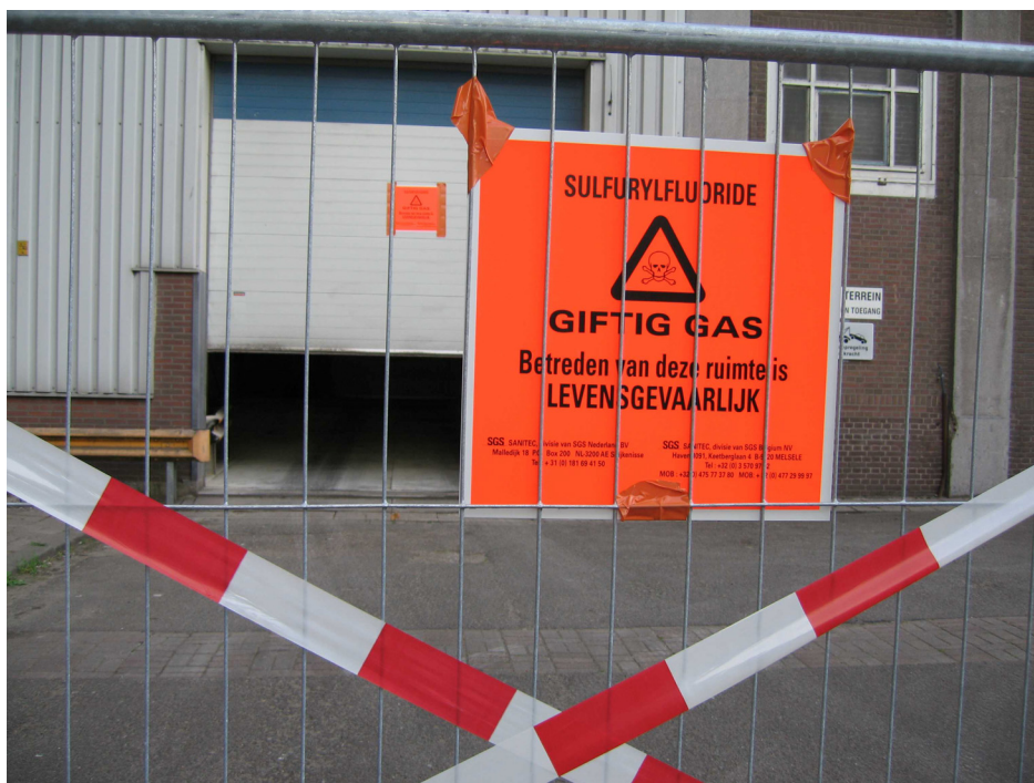
Figuur 2: Waarschuwing en afzetting rondom het gebouw.
