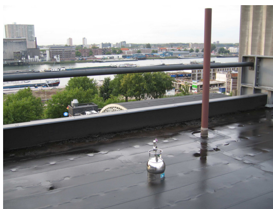
Figuur 8: Canister op dak van bedrijfsgebouw naast mangat vijfde verdieping.
