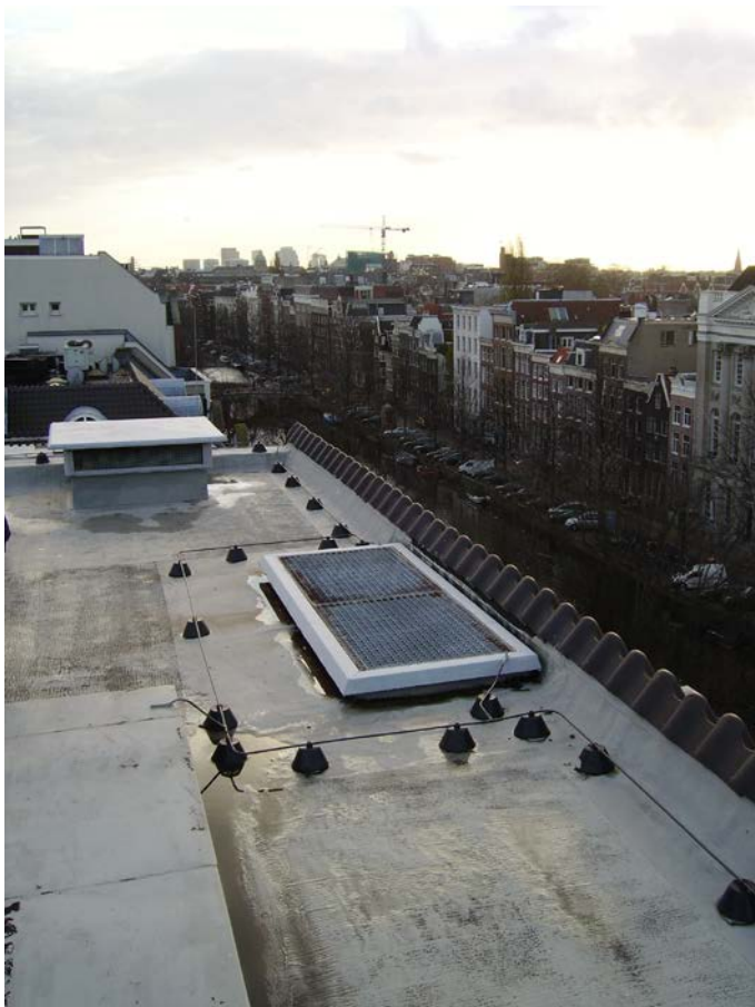
Figuur 5. Natte koeltoren met weggewerkte uitblaasopening (bron: Alvin Bartels, Groundworks)
