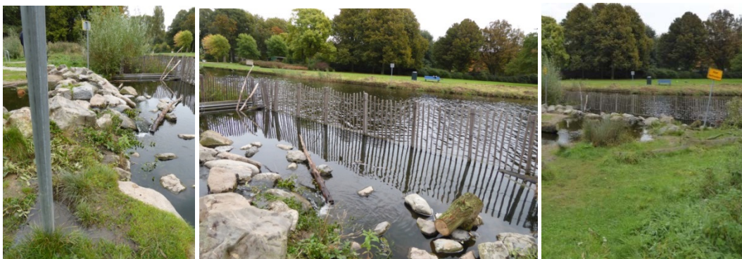
Figuur 14 Stenen afbakening aan de uitlaat van de beek in het Zuiderpark
