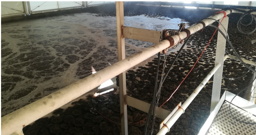
Afbeelding 5.1. Voorbeeld van een beluchtingsbassin waarbij de hexacovers naar de zijkant drijven toen de beluchting werd aangezet.
