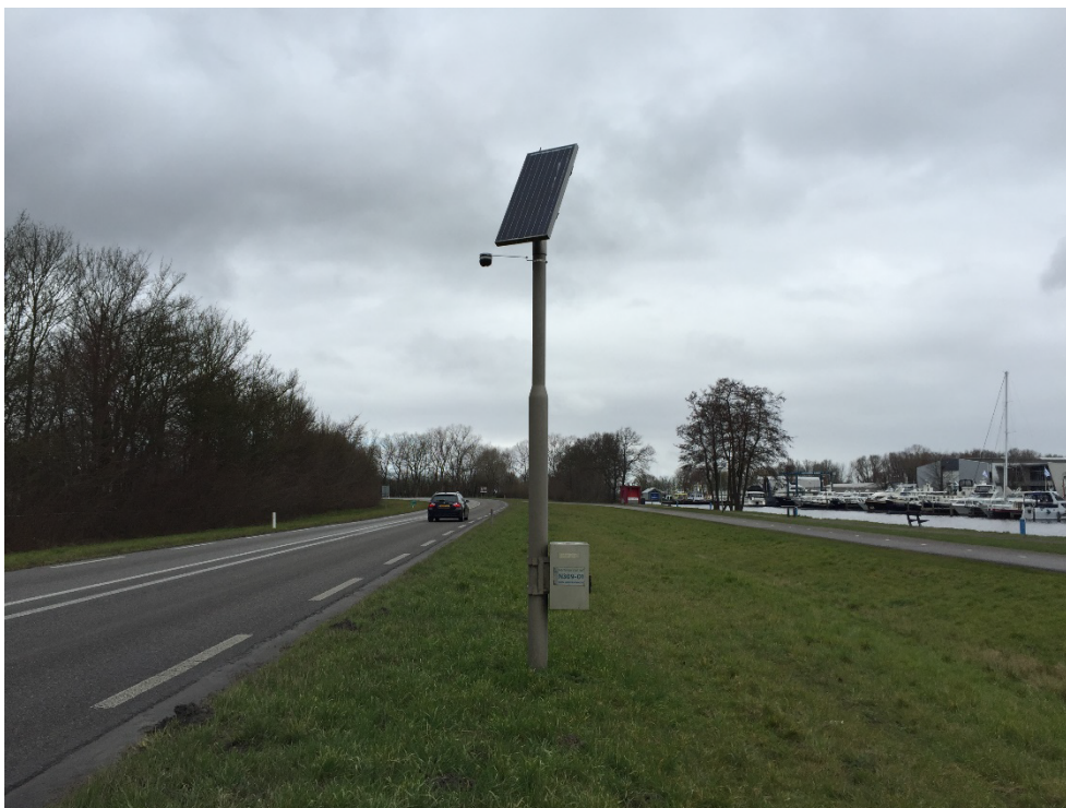
Figuur 1 De meetopstelling langs de N309 bij Elburg.
