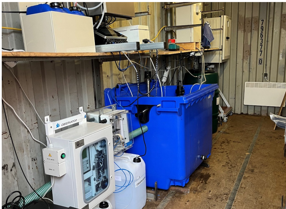
Figuur 6 Doorstroomreservoir (blauwe container) en opstelling meetproef.
