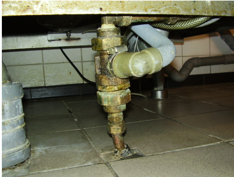
Verkeerde beveiliging met eigen 'afvoer' van overdruk water
