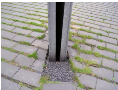
Goot voor transport van opgevangen hemelwater naar het reservoir
