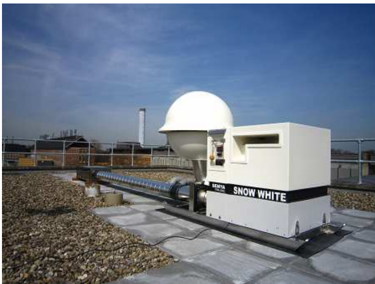
Foto 1 Bemonstering van luchtstof met de nieuwe Snow White opstelling, op het dak van het Cohen-gebouw van het RIVM. Debiet: 800 m 3 /h.
